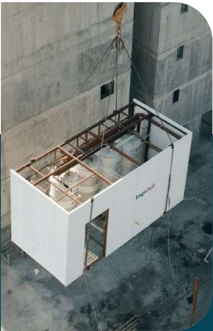
Inspección Técnica Especializada de los componentes del módulo.
