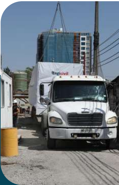
Supervisión del proceso de fabricación, traslado e izaje.
